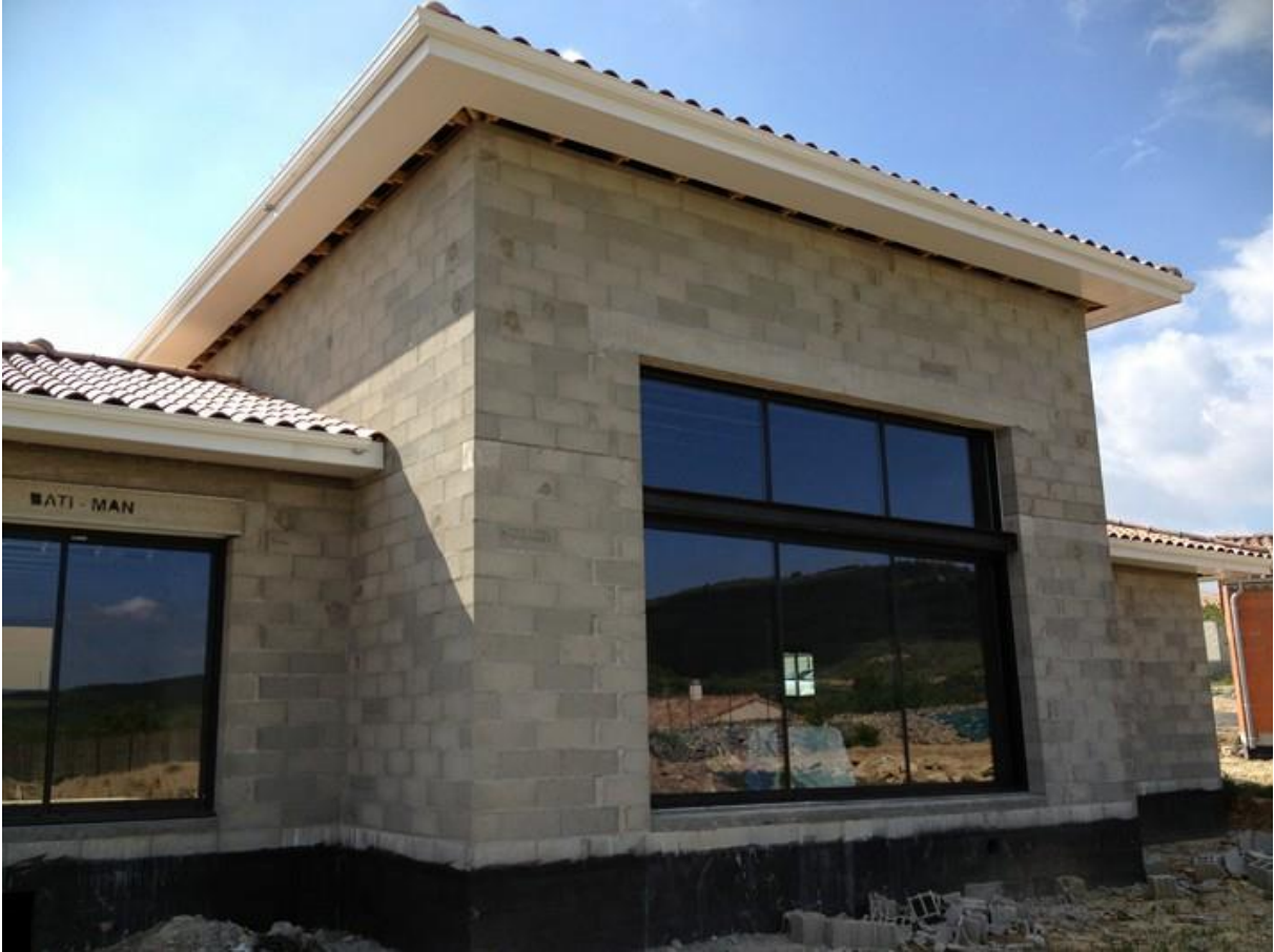
Avancée de toit :
